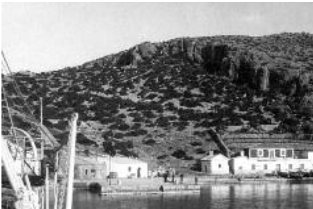
Izquierda. Espigón del puerto de Cabrera, varadero y muelle de ribera, antes de la prolongación en 1955. (AH)
