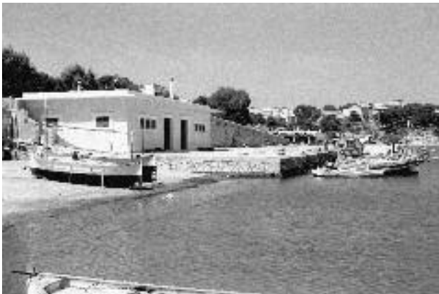
Izquierda. Muelle y varadero de Portocristo ya con edificaciones para servicios en 1961. (SP)
