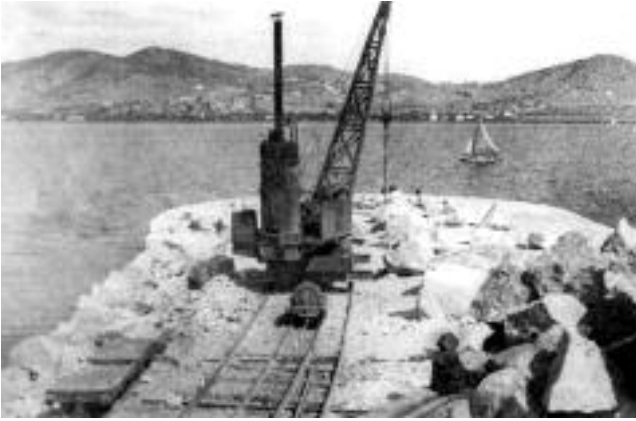
Izquierda. Morro del actual dique de Eivissa en construcción a final del siglo XIX. (FR)
