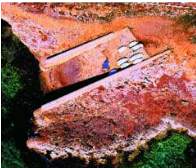
Instalación portuaria de sa Ràpita. (CAIB)
