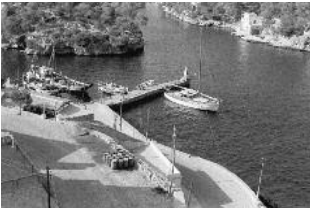
Izquierda. Dique de Cala Figuera y rampa de acceso (ca. de 1959). (SP)
