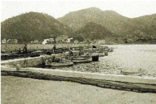
Izquierda. Dique interior histórico del puerto de Andratx con el arranque del Muelle de Ribera recién ampliado (ca. 1955). (SP)
