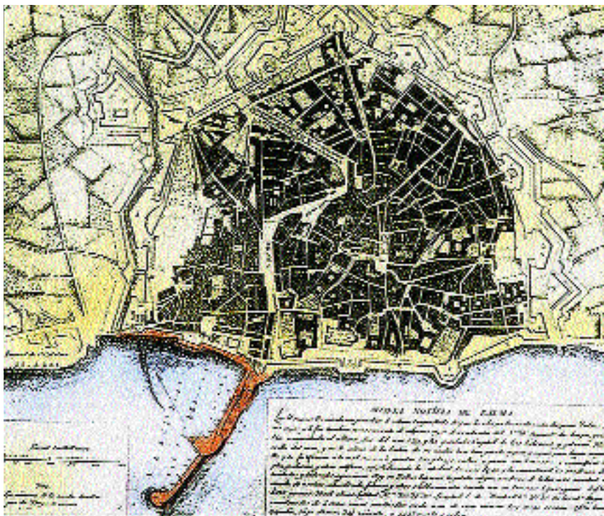
Plano de 1831 de Lorenzo M. Muntaner de la ciudad de Palma. Muestra los escollerados del Contramuelle y una avería en el manto de escollera del «Moll Vell»; el Muelle Nuevo ya se encuentra grafiado. (CP)
