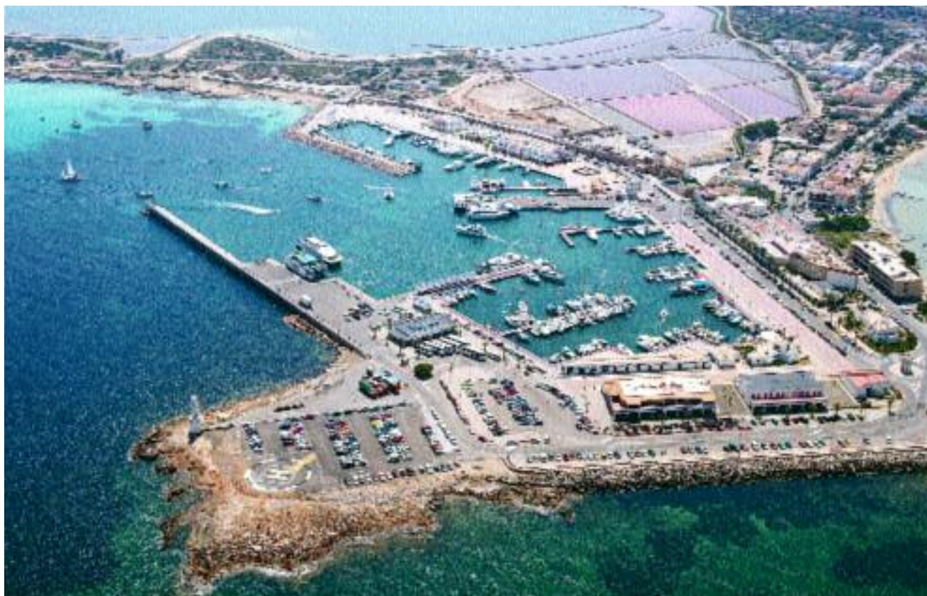
Puerto de La Savina. (APB)
