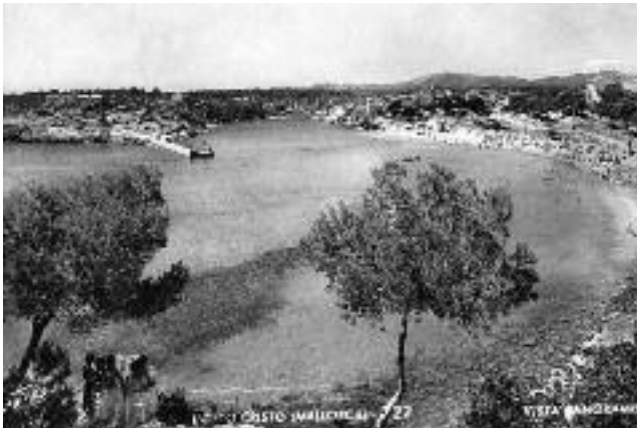
Izquierda. Portocristo tras construir el dique basculando la playa (ca. 1955). (AM)
