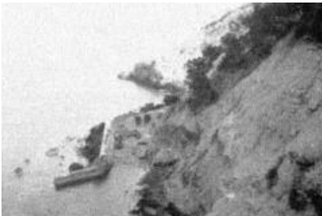
Izquierda. Rampa varadero con bóvedas de hormigón en «sa Pedra de s'Ase» de Banyalbufar. Año 1948. (MP)
