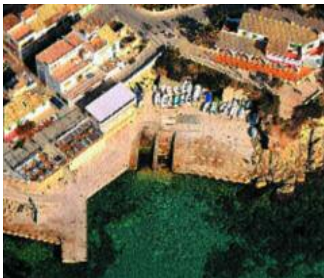
Instalación portuaria de Sant Elm. (CAIB)
