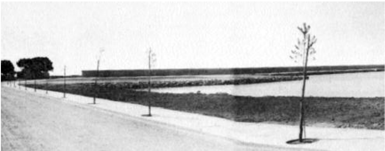
Puerto de Alcúdia en 1955 con el nuevo dique y muelle de ribera primitivo con su carretera de servicio ya terminados. (MP)
