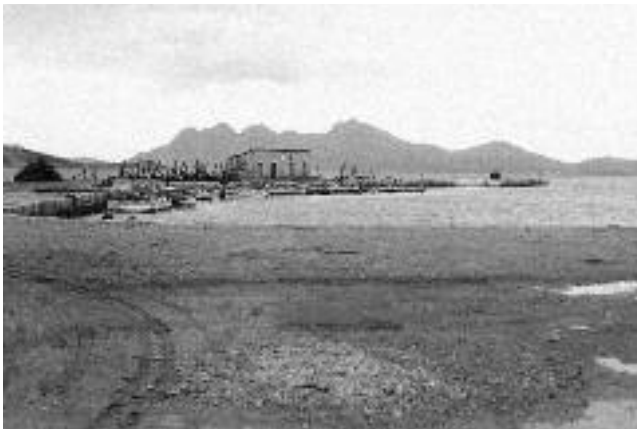
Izquierda. Muelle de Pollença con el inicio de la mejora del puerto (ca. 1947). (SP)
