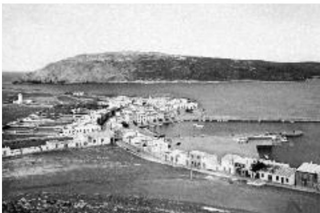
Izquierda. Dársena pesquera de Fornells antes de las averías del dique y de la construcción del espaldón (ca. 1954). (SP)
