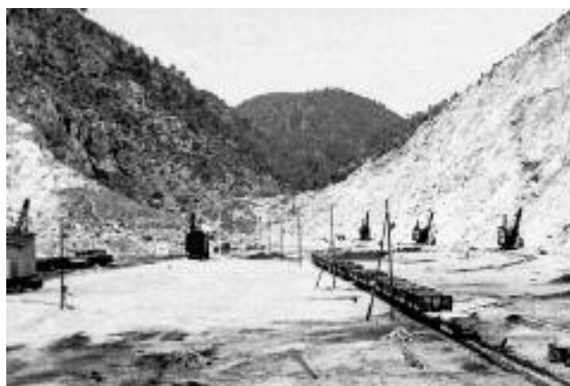
Derecha, abajo. Una de las palas a vapor sobre carriles removiendo escollera en la cantera de Génova en 1955 para la construcción del dique del Oeste en Palma. (DS)
