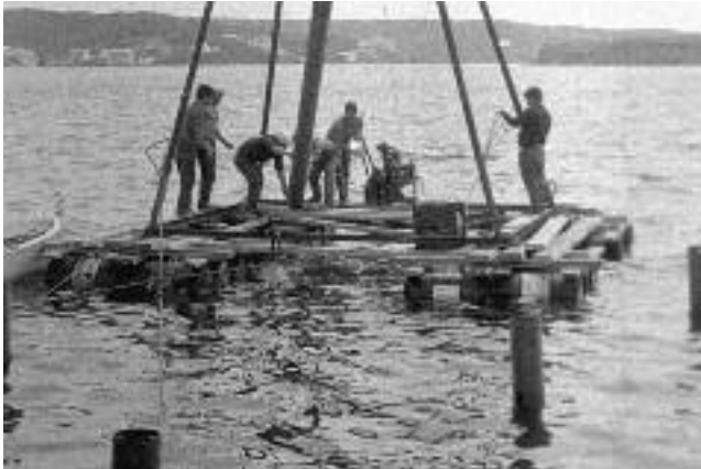
Izquierda. Rudimentaria hinca de pilotes en pantalanés en los puertos de Sóller y Maó en 1967 (Maó). (SP)
