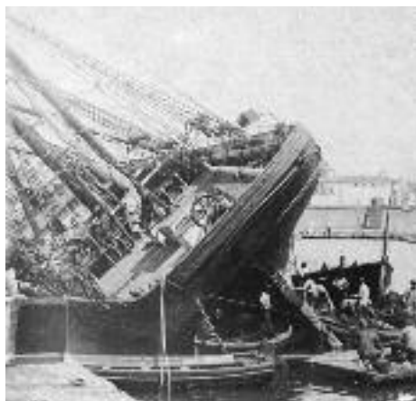
Izquierda. Carenado de un buque a flote en el Contramuelle de Palma hacia 1900. En Eivissa debió hacerse en s'Espalmador a juzgar por su nombre. (AM)
