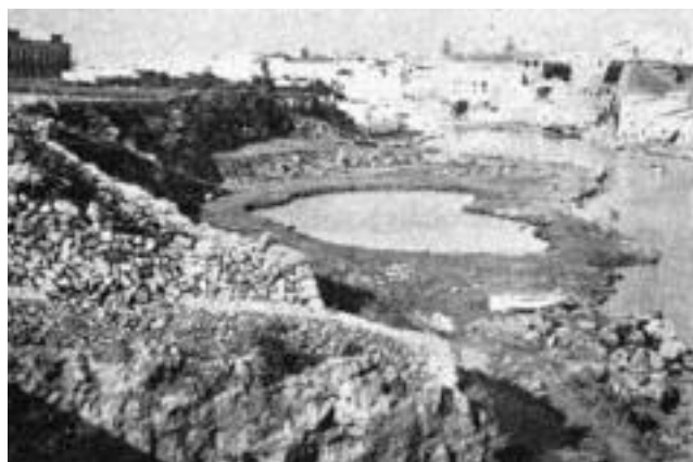
Izquierda. Cala Rajada hacia 1946 con el primitivo varadero y muelle de ribera en ejecución. (AH)
