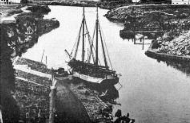
Izquierda. Inicio de las primeras obras de ensanche del puerto de Ciutadella (1935). (CM)
