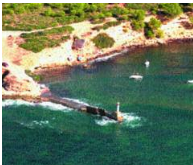
Instal·lació portuària des Caló (Ferrutx). (CAIB)
