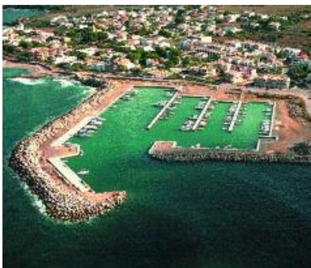
Instal·lació portuària de la Colònia de Sant Pere. (CAIB)
