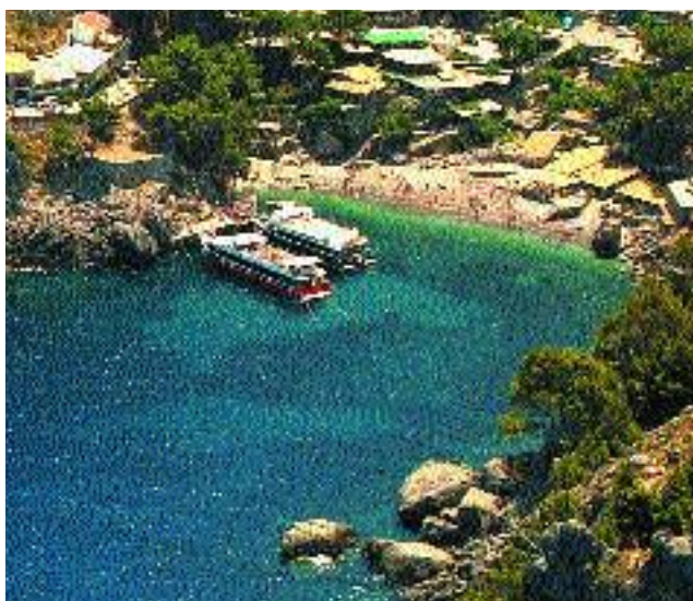
Instal·lació portuària de sa Calobra. (CAIB)
