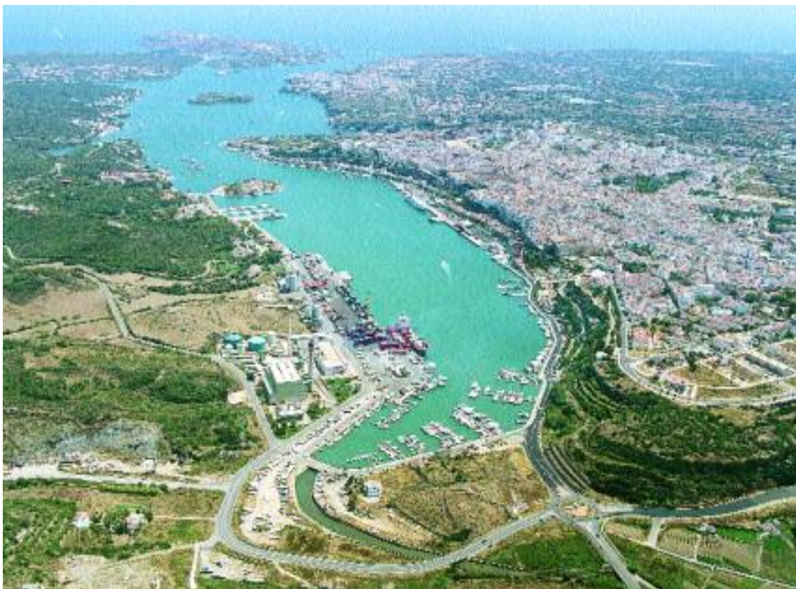
Port de Maó. (APB)
