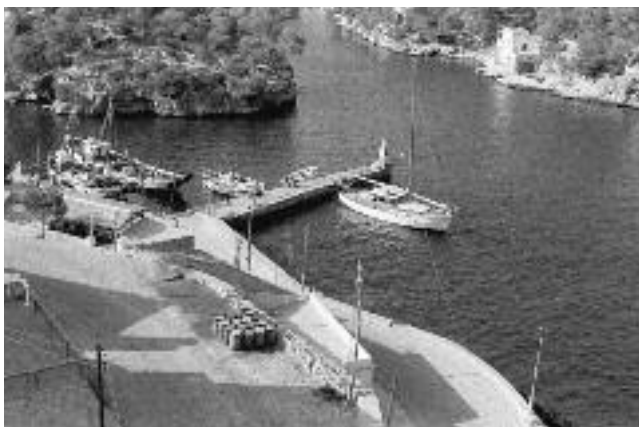
Esquerra. Dic de Cala Figuera i rampa d'accés (c. de 1959). (SP)
