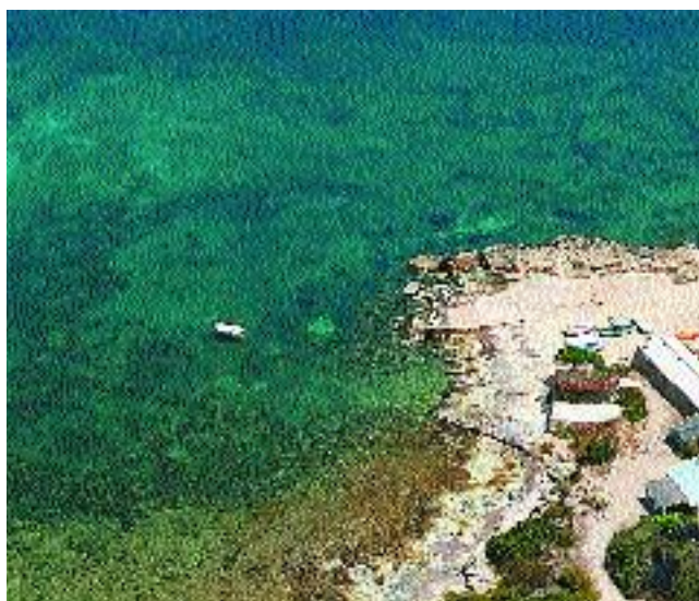
Instal·lació portuària de s'Estantol II. (CAIB)
