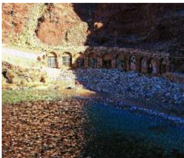
Instal·lació portuària des Port (Estellencs). (CAIB)
