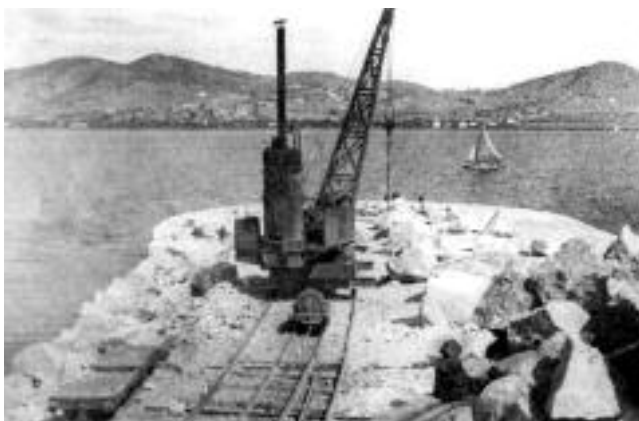
Esquerra. Morro de l'actual dic d'Eivissa en construcció al final del segle XIX. (FR)
