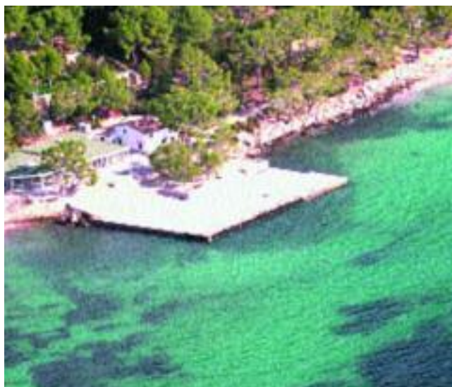
Instal·lació portuària de Formentor. (CAIB)
