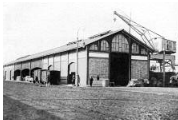
Dreta. Antic cobert de Barcelona a la prolongació del Moll Nou de Palma el 1925. (MP)
