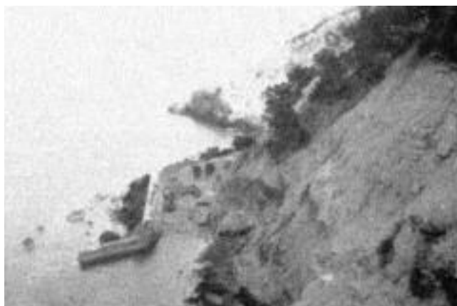
Esquerra. Rampa varador amb bòvedes de formigó a sa Pedra de s'Ase de Banyalbufar. Any 1948. (MP)
