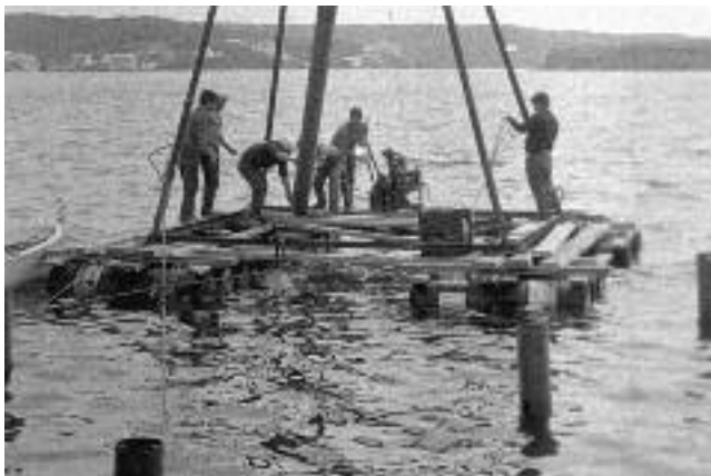
Esquerra. Rudimentària clavada de pilons a pantelans als ports de Sóller i Maó el 1967 (Maó). (SP)
