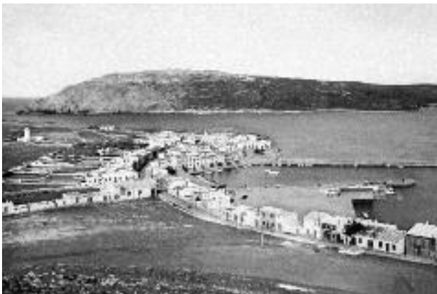
Esquerra. Dàrsena pesquera de Fornells abans de les avaries del dic i de la construcció del mur de la riba (c. 1954). (SP)
