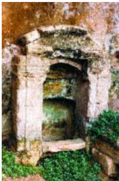
Nimfeu d'època romana per a aiguada a Cala Figuera, possiblement la instal·lació portuària més antiga, d'aquest tipus, d'Europa (Port de Maó). (AP)
