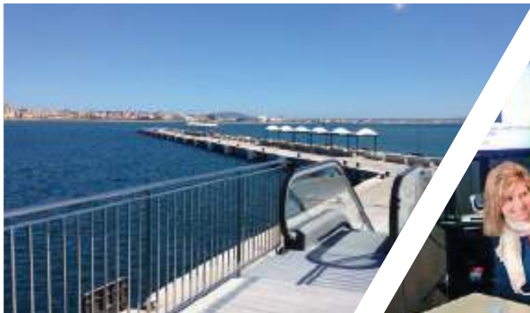
Finalización de las obras de mejora para el embarque de pasajeros de cruceros en los muelles de Poniente.
