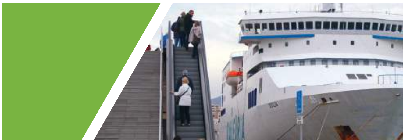
Finalización obras de mejora de los accesos a la primera planta de la Estación Marítima número 1 del puerto de Palma, con el objetivo de facilitar el embarque y desembarque de los pasajeros de cruceros que atracan en la ampliación de los muelles de Poniente (9/03/2015)
