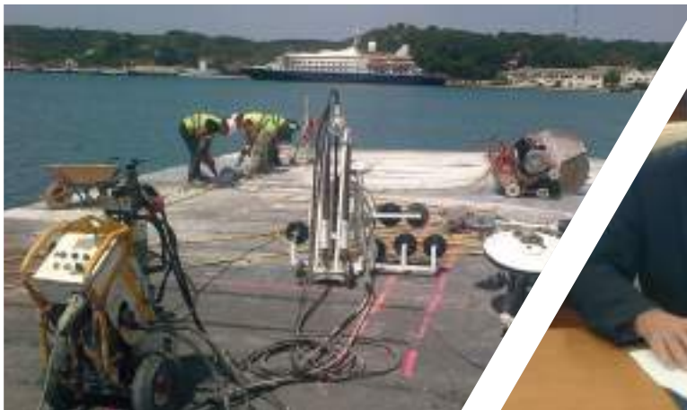
Demolición del tacón ro-ro del muelle de Pasajeros del puerto de Maó
