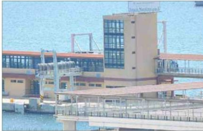
El mismo edificio, en la actualidad, como sala de tránsito de pasajeros.
