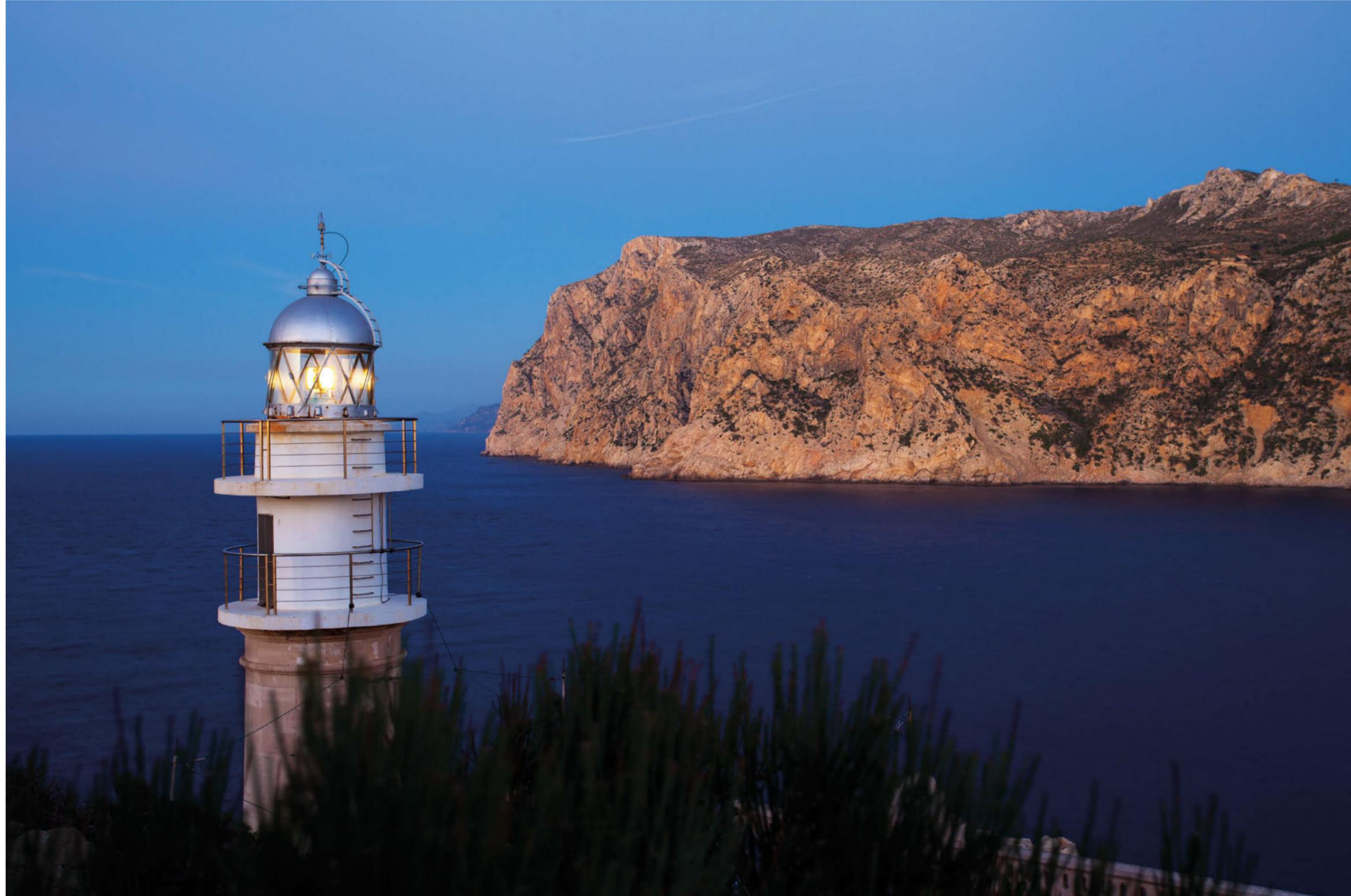
En el presupuesto del proyecto de reforma del far de Llebeig no s'inclou el preu de compra de la nova òptica i sistema Dalen, perquè ja s'havien adquirit l'any 1968.
