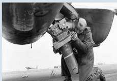
©RMM C119545 Càmera aèria F32 (dent de 36 polzades) instal·lada en un Haviland Mosquito. Arribada de Benson (Oxfordshire)
